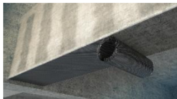
Primera capa de Protex FC Wrap Epoxy.
