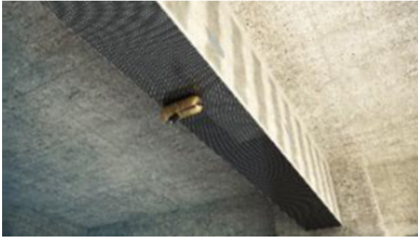
Segunda capa de Protex FC Wrap Epoxy.
