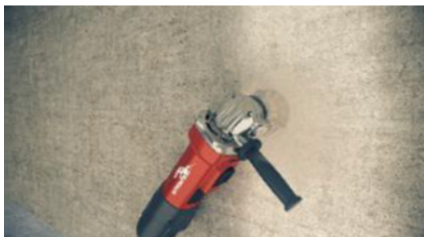
Preparación de la superficie.
