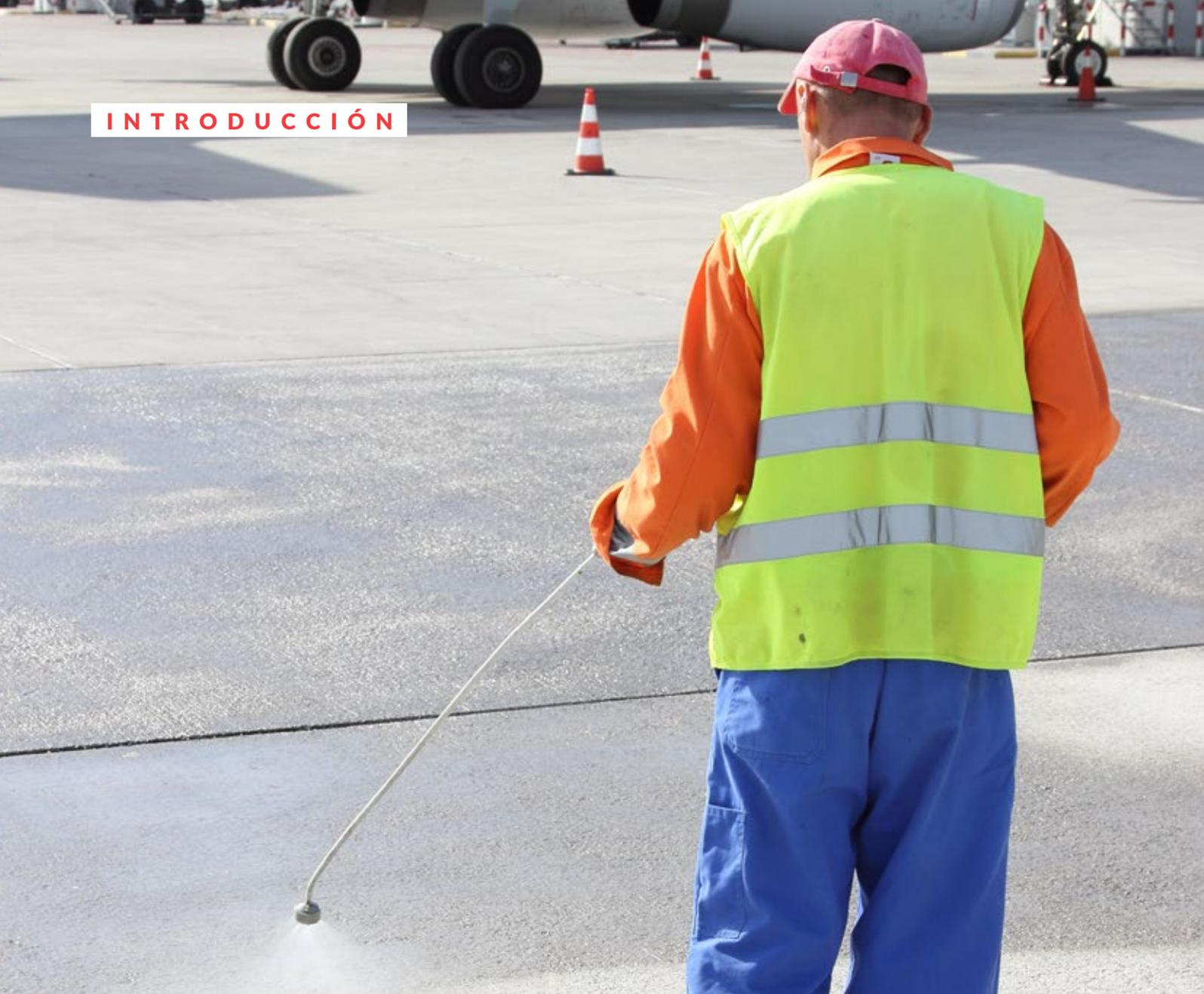
En resumen, la relación agua:cemento, es uno de los parámetros que más debe cuidarse en el diseño y posterior proceso de fraguado y endurecimiento del hormigón. Por esta razón, resulta crucial limitar su pérdida por evaporación en las primeras etapas del proceso de fraguado y endurecimiento.
