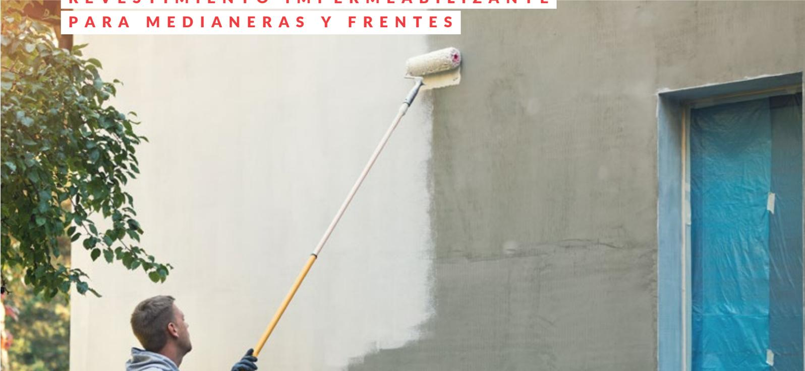
**DESCRIPCIÓN:** Revestimiento acrílico elastomérico impermeable, decorativo y protector, de alta resistencia a los cambios climáticos. Protege y decora las paredes exteriores y se mantiene impecable durante años.
